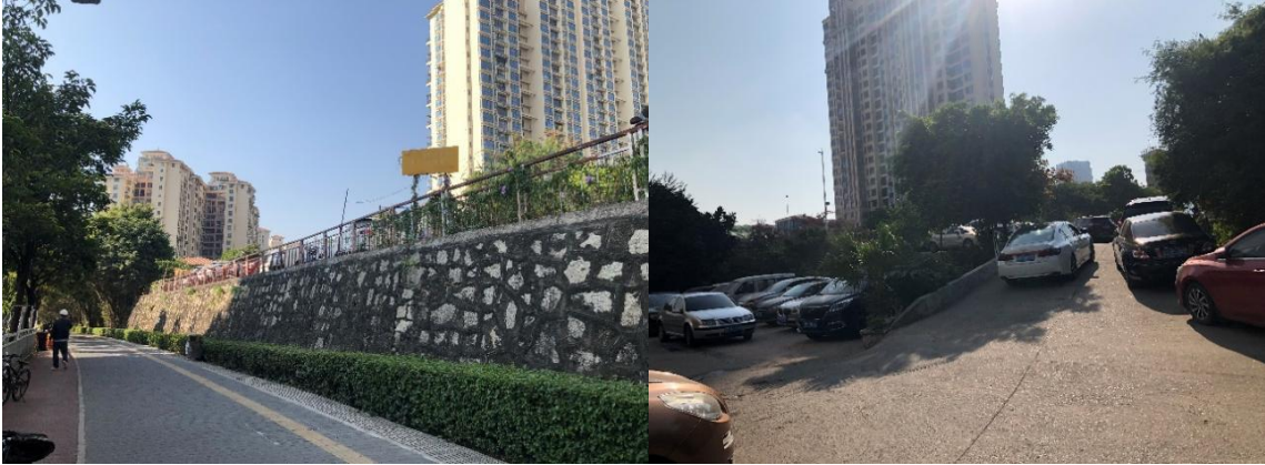
(左图为场地东侧边坡挡墙，右图为场地东侧停车区)
