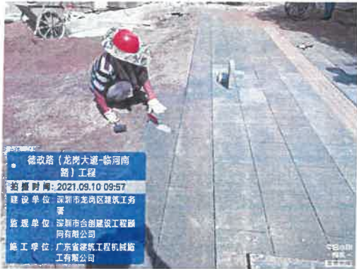
图 1 项目施工期人行道透水砖铺装
