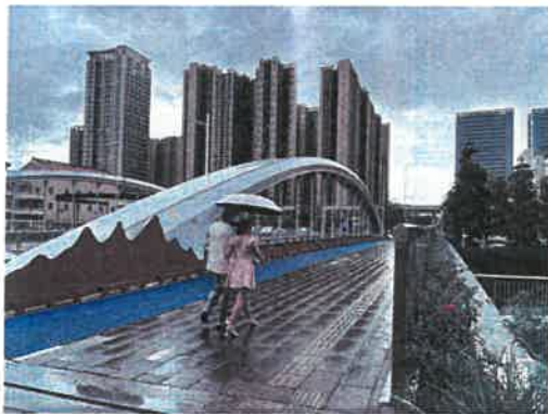
图 5 项目现状照片
