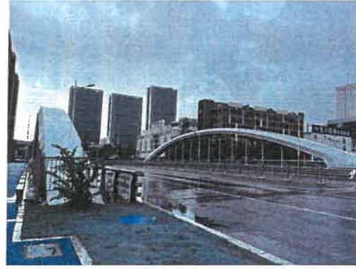
图 6 项目现状照片
