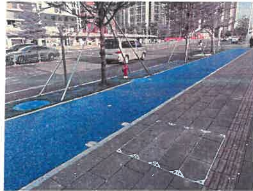
图 2 项目现状照片
