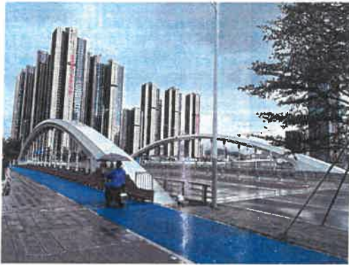
图 3 项目现状照片
