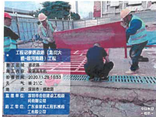
图 2 项目施工期平台安装
